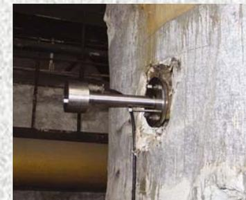
Устройства контроля факела и газоанализатор кислорода на энергоблоке тепловой станции ТС 1 ННЦ СО РАН
