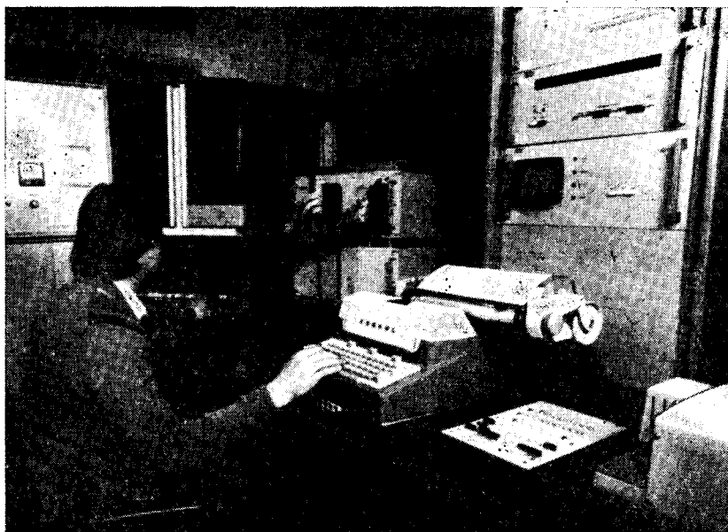
Рис. 4. Управляющий вычислительный комплекс со специализированным процессором.
